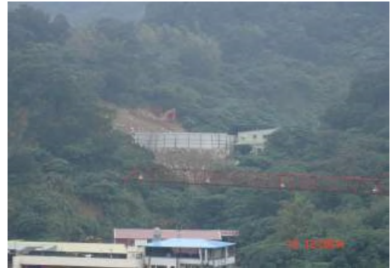
山坡地非法廢棄物掩埋場
