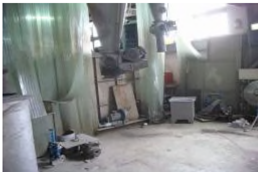
C-0102含鉛集塵灰貯存區無廢棄物名稱及有害特性標示
