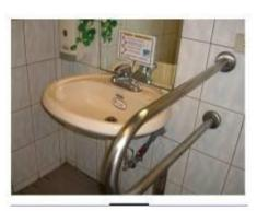
洗面盆未設置包覆扶手, 一側固定扶手妨礙乘坐輪 椅者接近使用。
