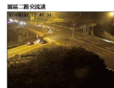
智慧型交通號誌控制中心 / 路口影像系統
