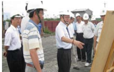
顏局長視察宜蘭園區工地
