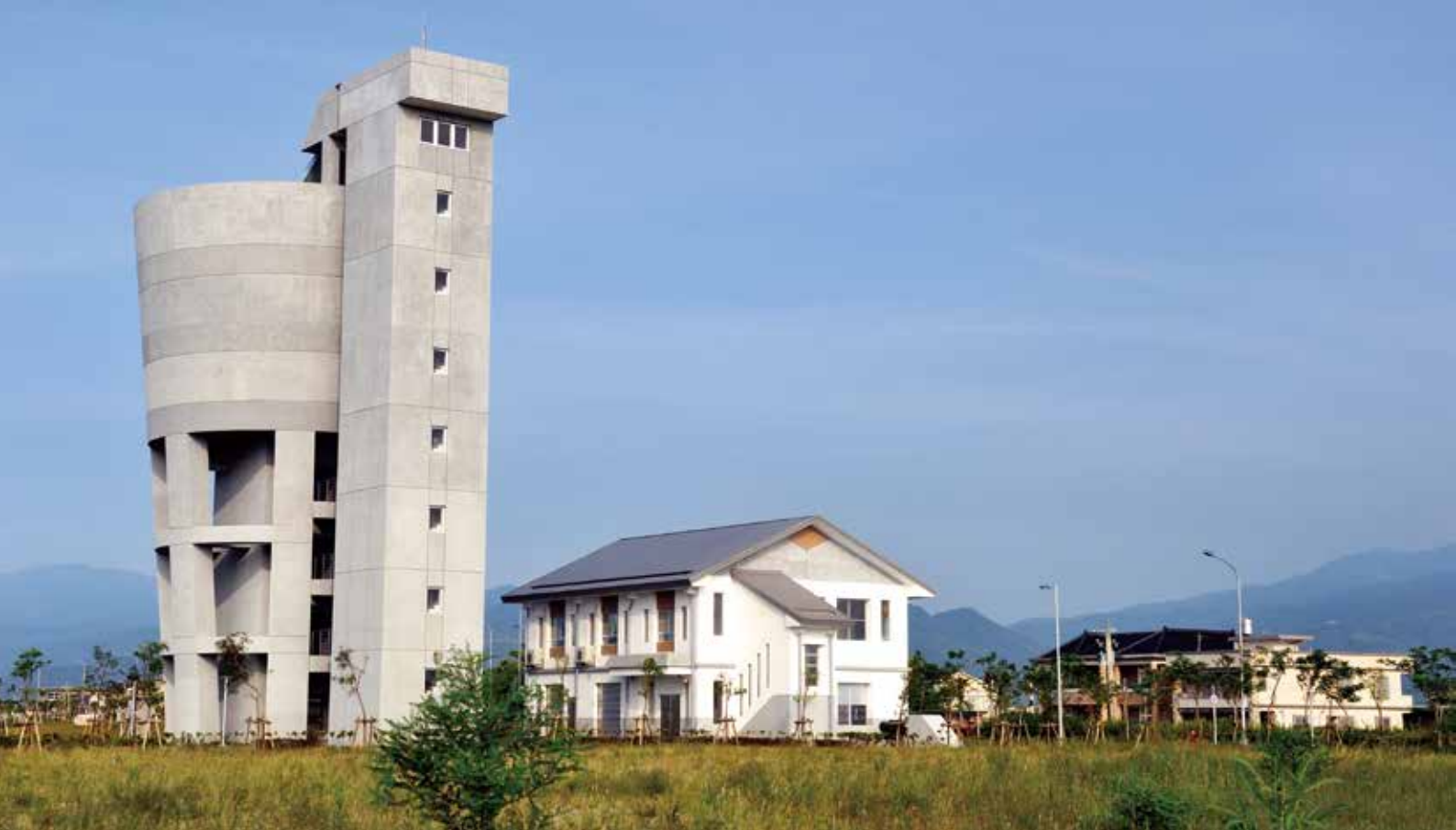
宜蘭園區高架水塔
