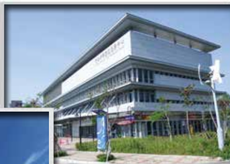
竹南園區（服務中心大樓）
