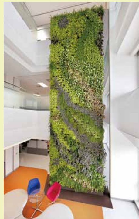
綠建築辦公大樓內部跨樓層之植生牆
