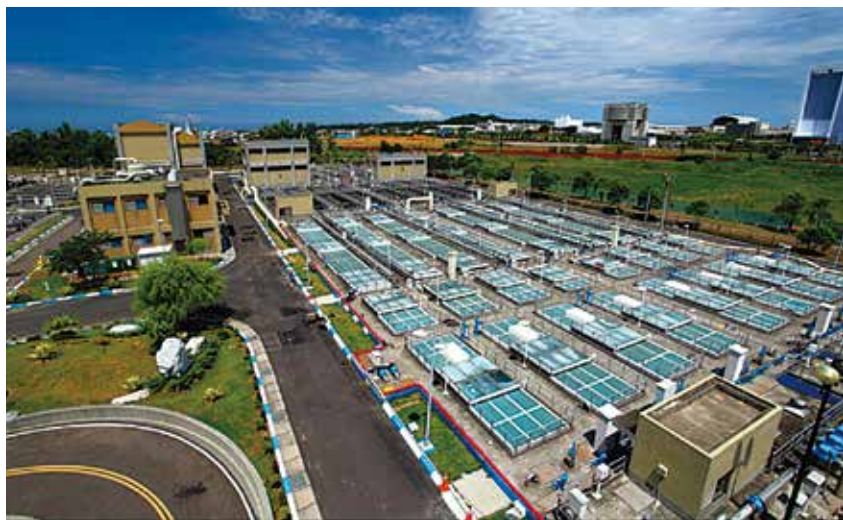
竹南園區污水處理廠
