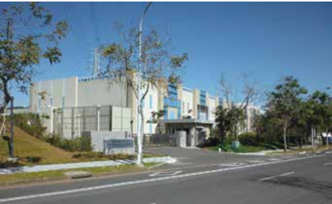
超高壓變電所
