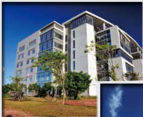
新竹生醫園區（生技大樓）
