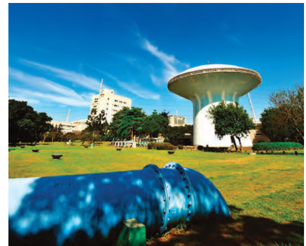
位於高速公路旁的高架水塔是園區的經典地標，提供充足、穩定及安全的供水。
