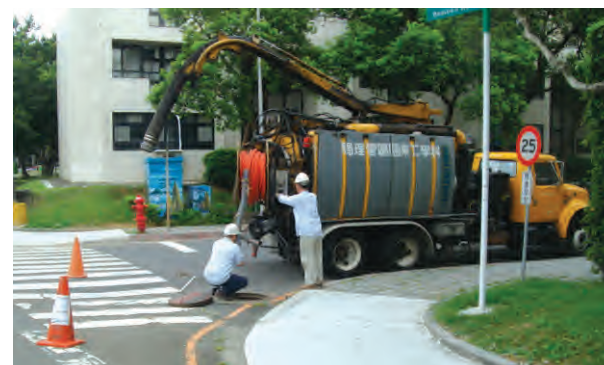
協助社區雨水下水道疏浚
