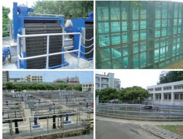
新竹園區污水處理廠主要操作單元
