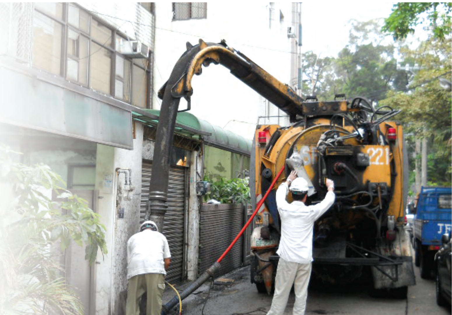
協助社區雨水下水道疏浚
