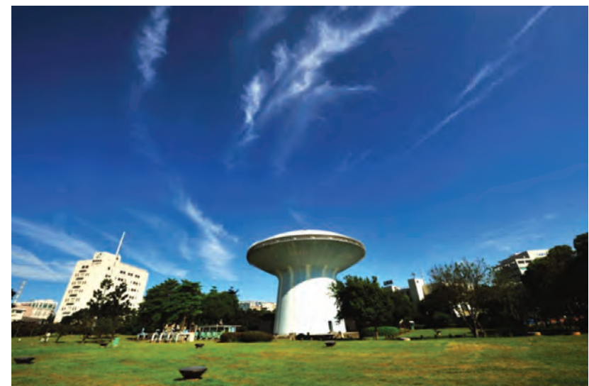
園區高架水塔，提供充足、穩定及安全的供水
