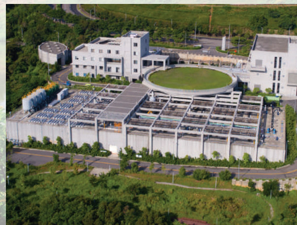
銅鑼科學園區污水處理廠
