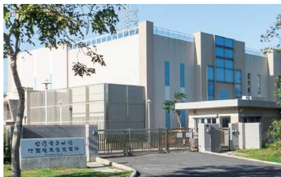
台灣電力公司 竹園超高壓變電所
