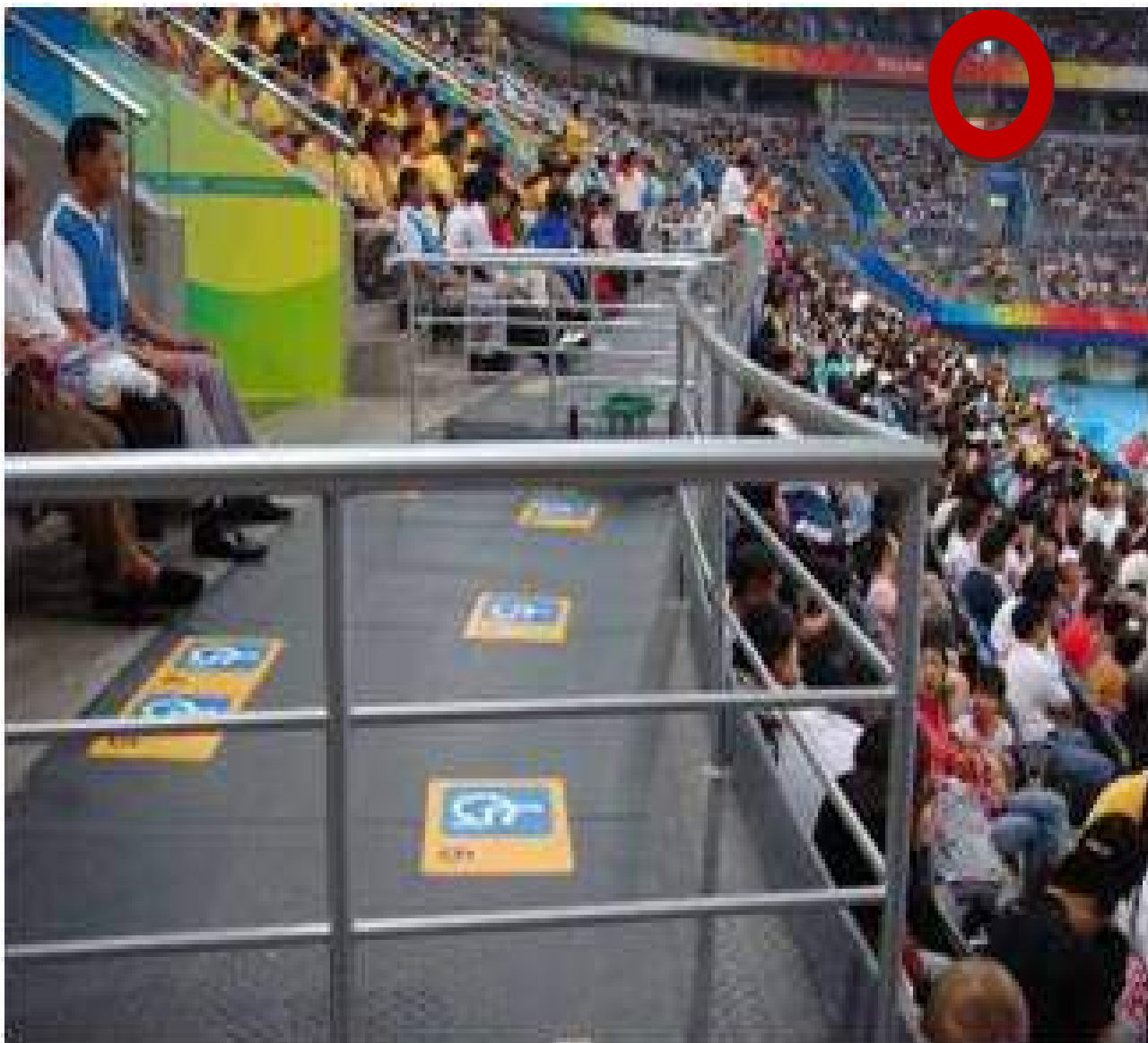
輪椅觀眾席位前有高差應設置欄杆，以防跌落。
