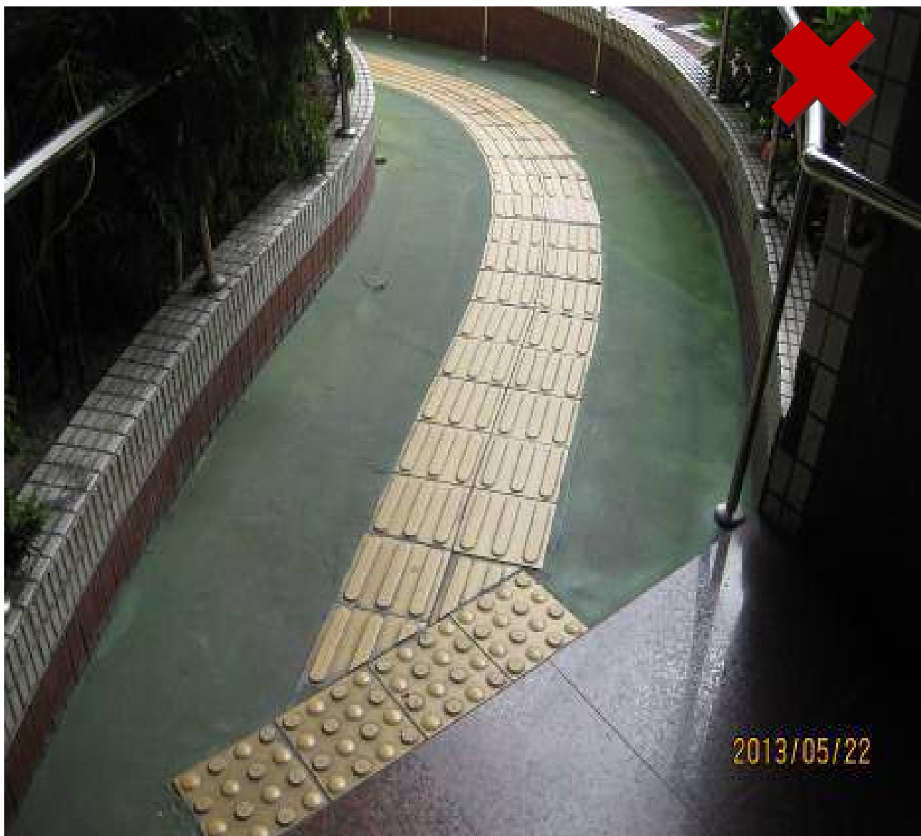
坡道地面不得設置導盲磚妨礙輪椅之通行。
