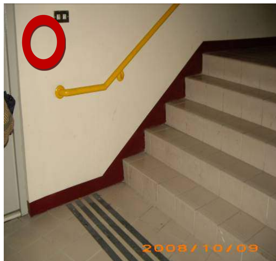
樓梯扶手端部固定於牆上防勾 撞
