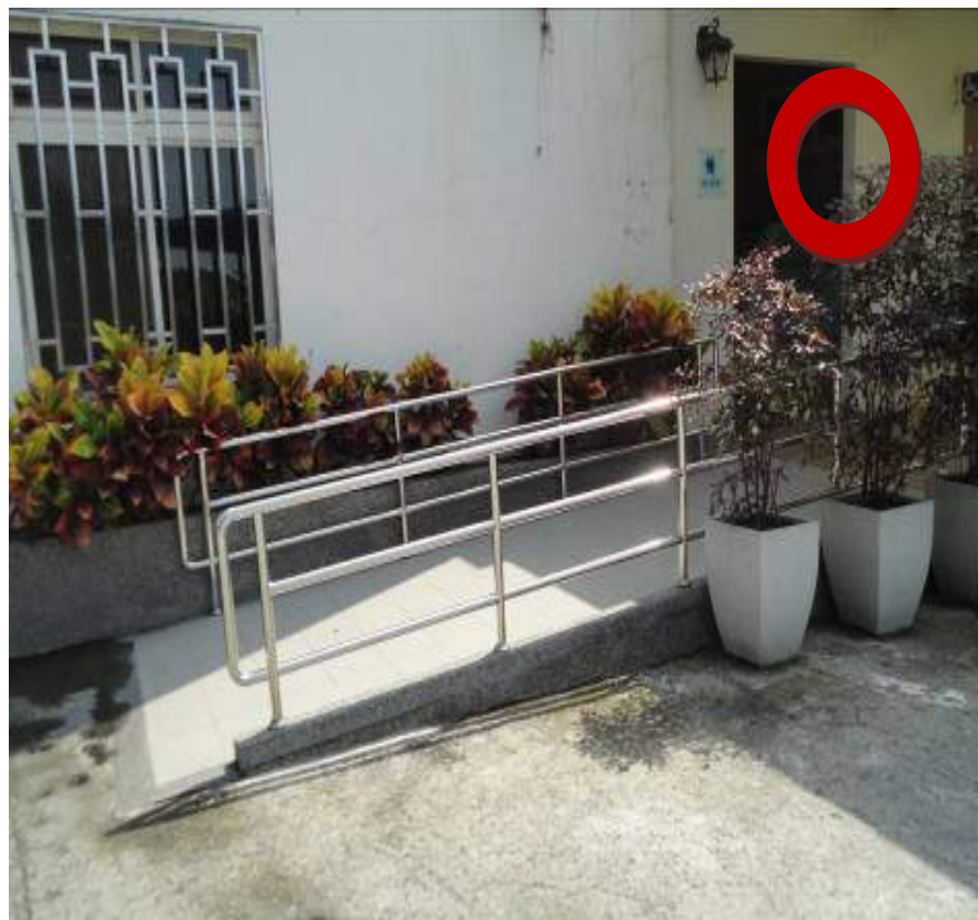
坡道扶手端部防勾 撞處理
