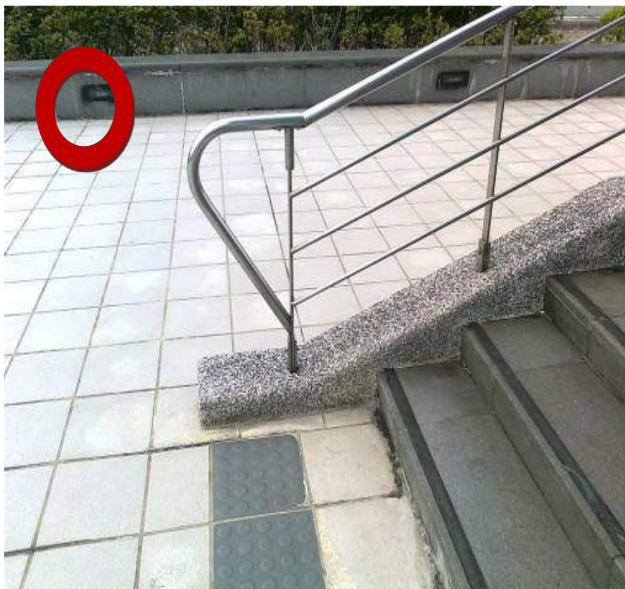
樓梯扶手端部防勾撞 處理
