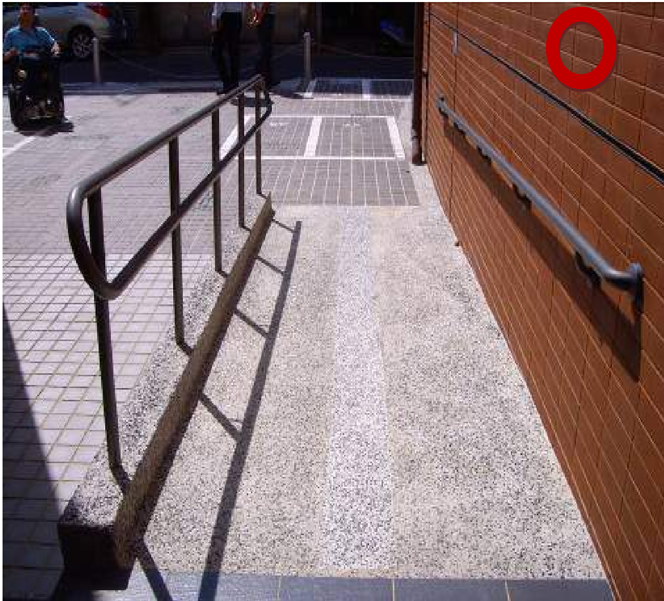
坡道防護緣不得超出扶手之垂直投影線外。
