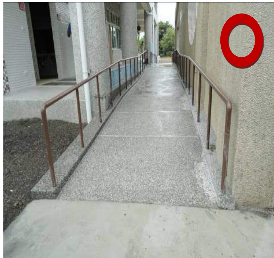
坡道扶手端部防勾撞 處理
