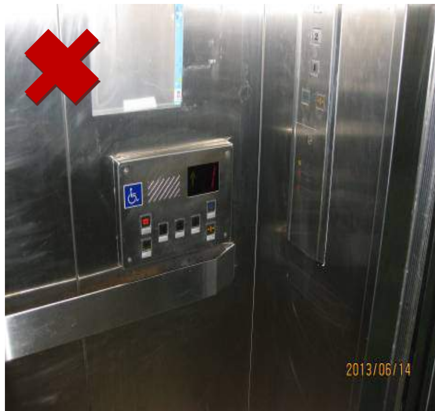
輪椅乘坐操作盤，距入口距離小於30公分，不方便操作。
