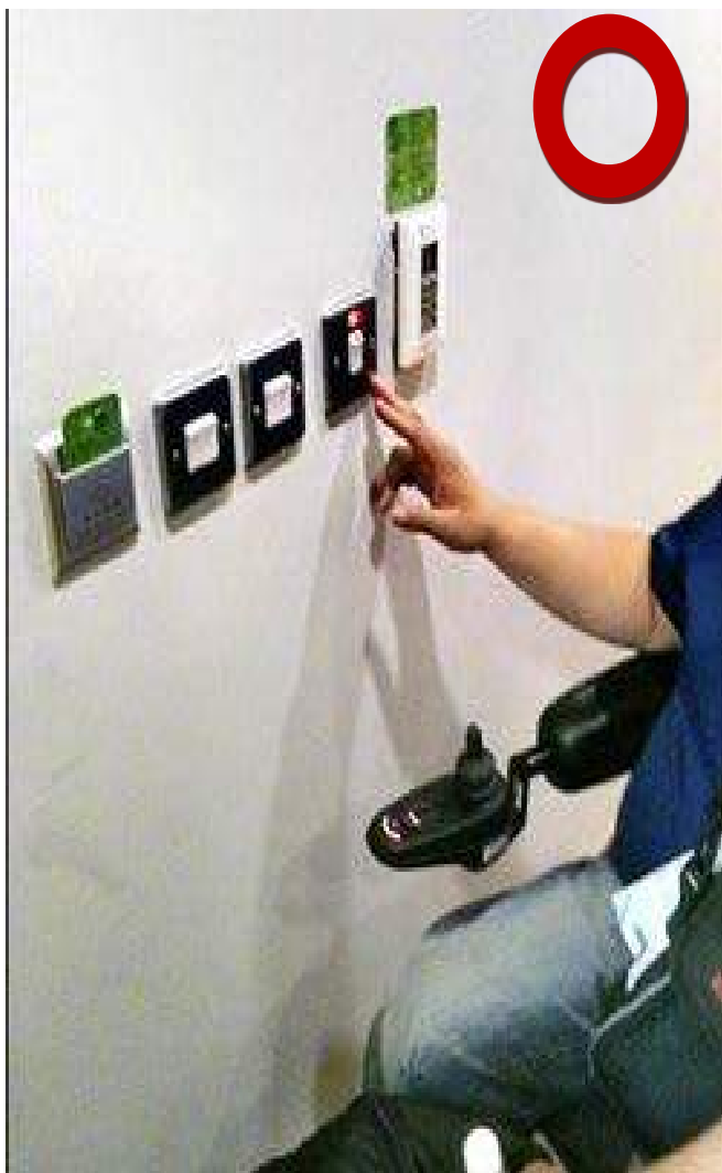
電器插座及開關應設置高度70-100公分處， 以方便輪椅乘坐者使用。
