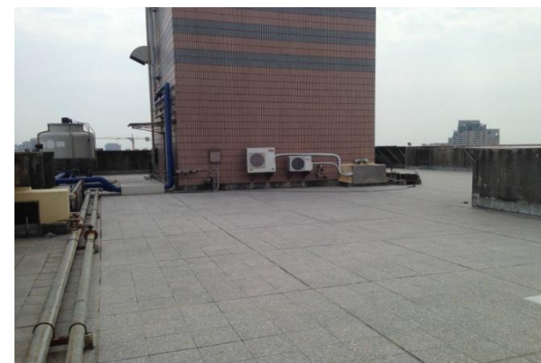
屋頂避難平台
