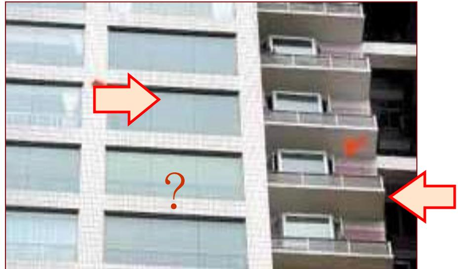
防火樓板應突出外牆面50cm以上，但與樓板交接處之外牆面高度達90cm以上，且外牆構造具有樓地板同等防火時效者，得免突出。
