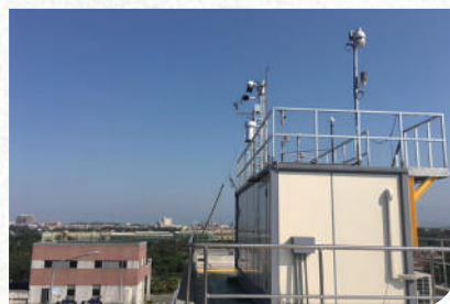
龍潭科學園區-龍潭服務處站
