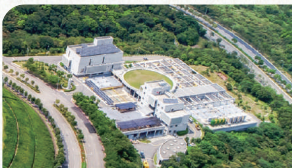
銅鑼科學園區污水處理廠
