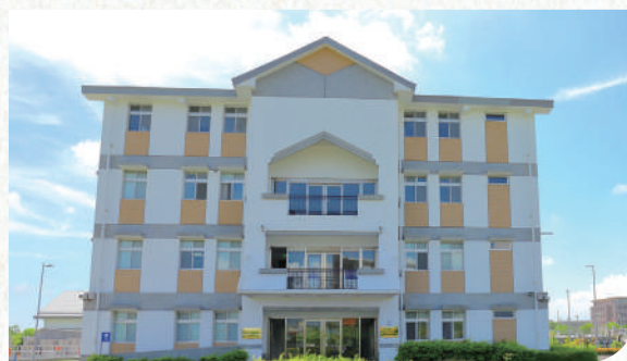
宜蘭科學園區污水處理廠
