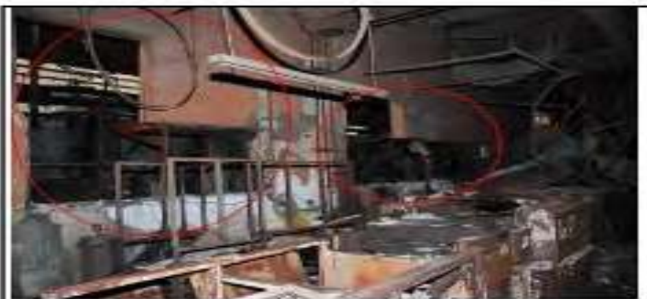
照片 4：南側牆面
