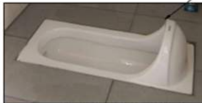
蹲式馬桶安裝正確方式
