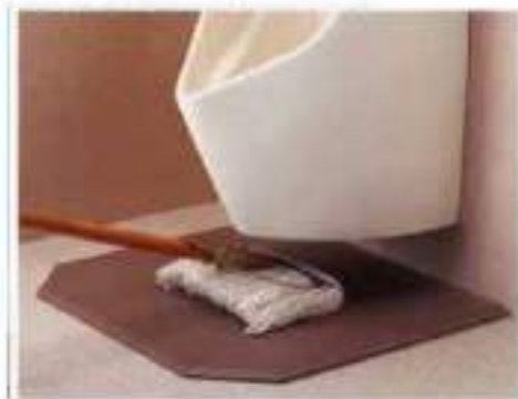
圖 3-26 小便器下方之清掃空間
