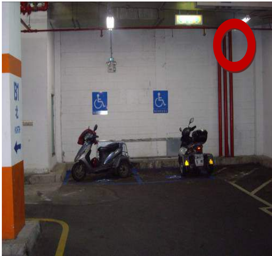
室內機車停車位及張貼無障礙標誌
