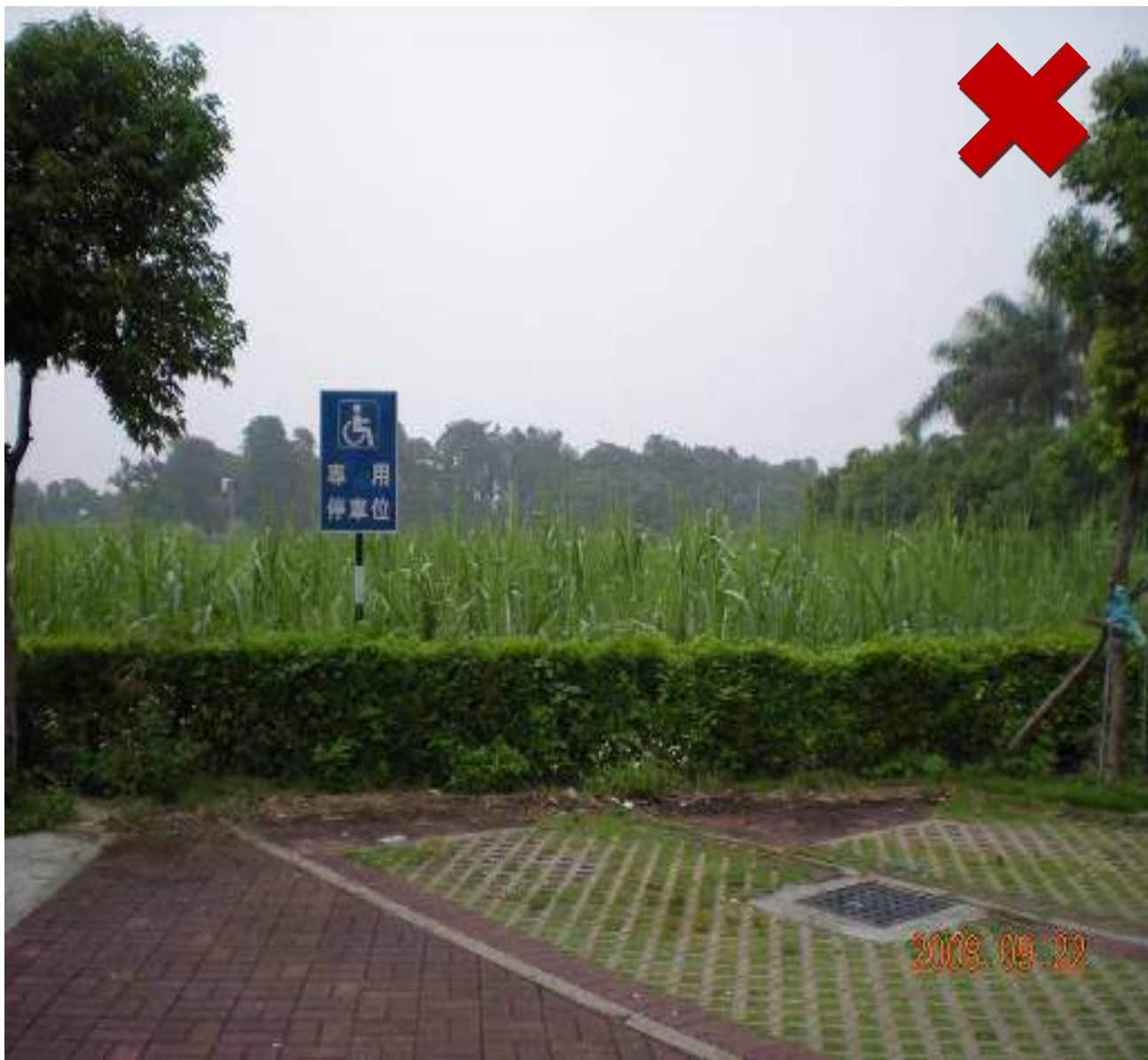
停車位路鋪設植草磚不適用於無障礙停車位。
