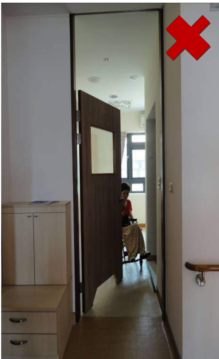
推開門未留設輪椅操作空間，使輪椅不方便進出。
