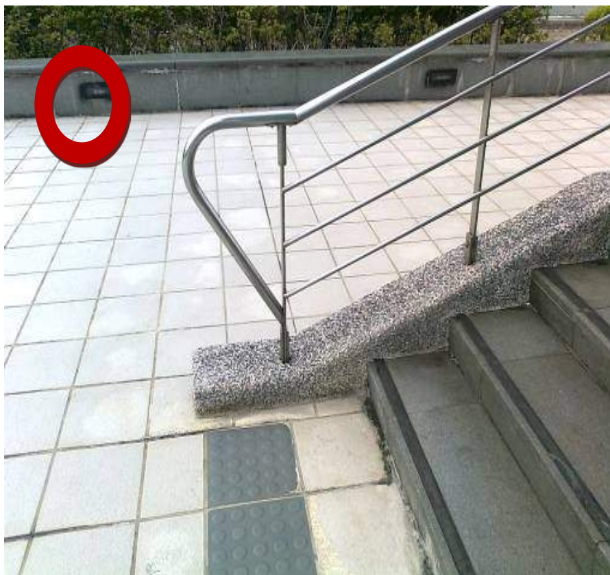
樓梯扶手端部防勾撞 處理
