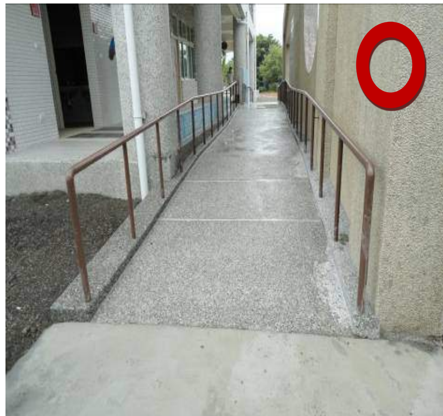
坡道扶手端部防勾撞 處理
