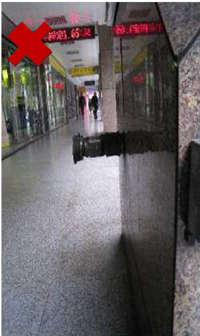
室外通路地面60-200公分之範圍，設置突出物，應設置警示或其他防撞措施。
