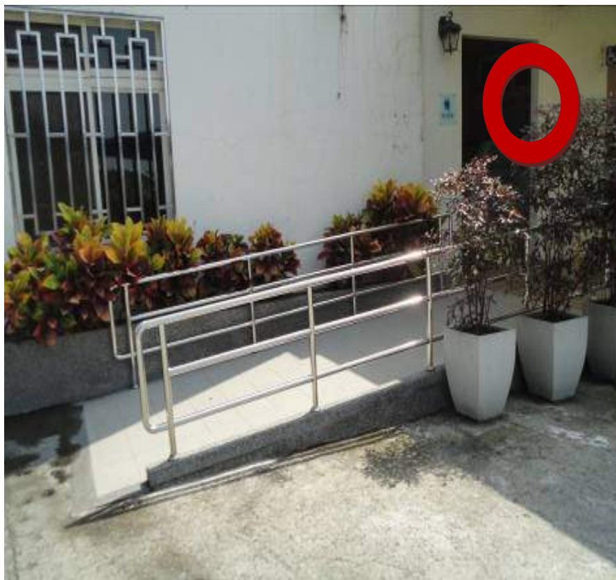
坡道扶手端部防勾 撞處理
