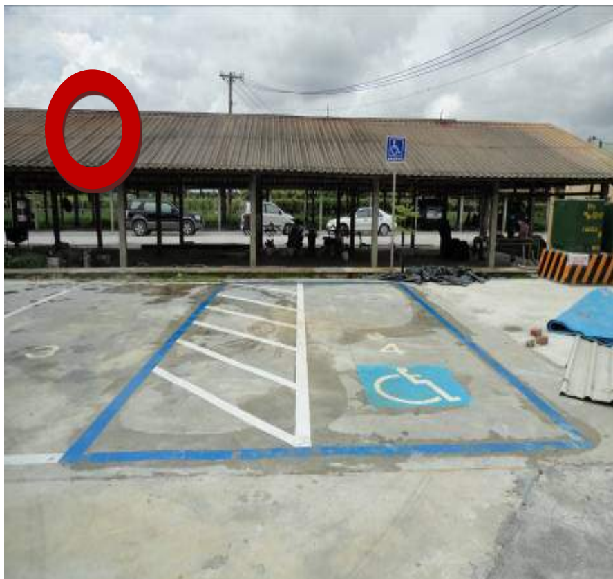
停車格線淺藍色，下車區為白色斜線及直線。
