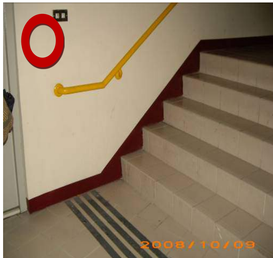
樓梯扶手端部固定於牆上防勾 撞
