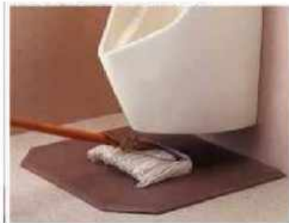
圖 3-26 小便器下方之清掃空間
