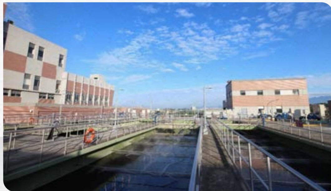
圖 3-4 龍潭科學園區污水處理廠
