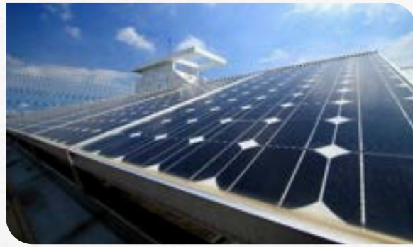
圖 4-6 竹科污水廠 - 行政大樓頂樓屋頂
