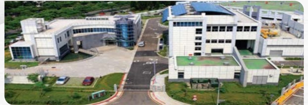
圖 3-5 新竹科學園區污水處理廠
