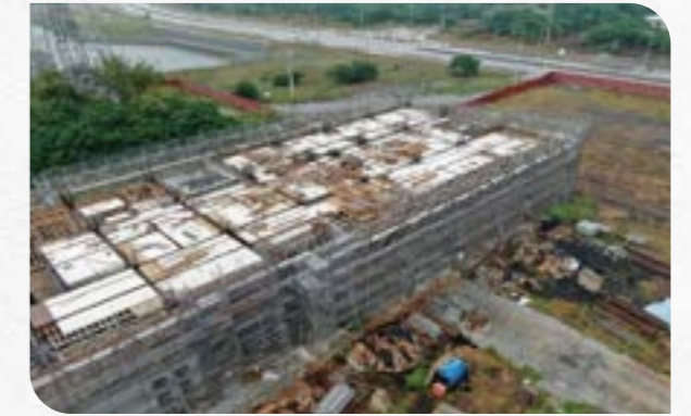
圖 2-4 空拍機協助工地巡檢
