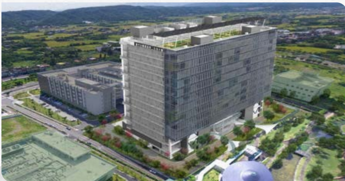
圖 6-10 第二生技大樓
