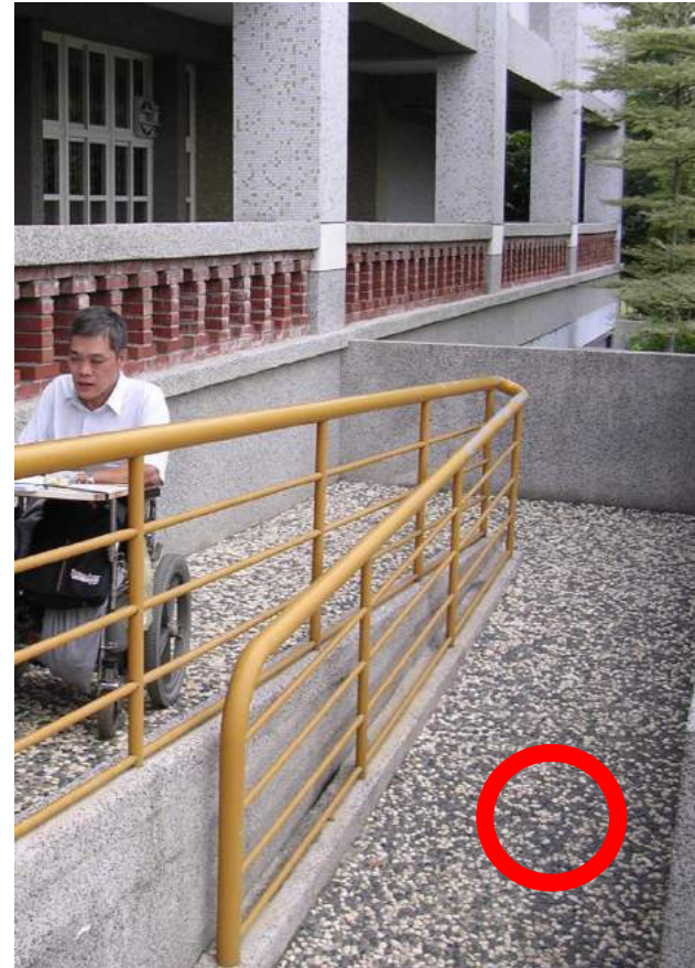
坡道扶手端部防勾撞處理
