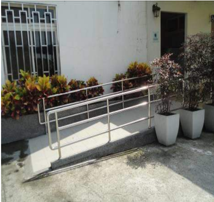
坡道扶手端部防勾撞處理
