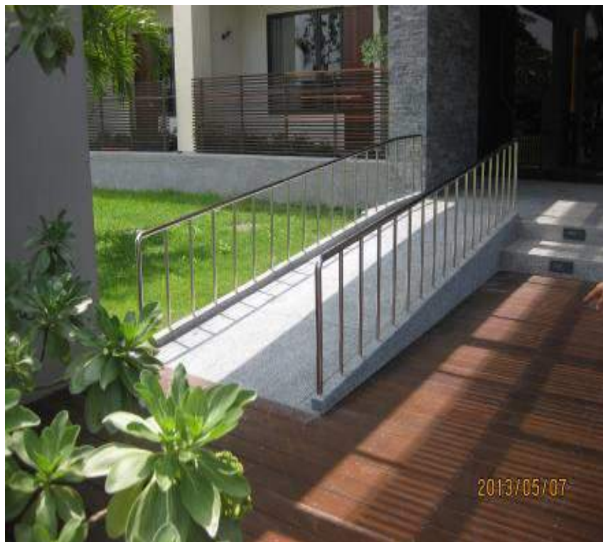
坡道端點平台
