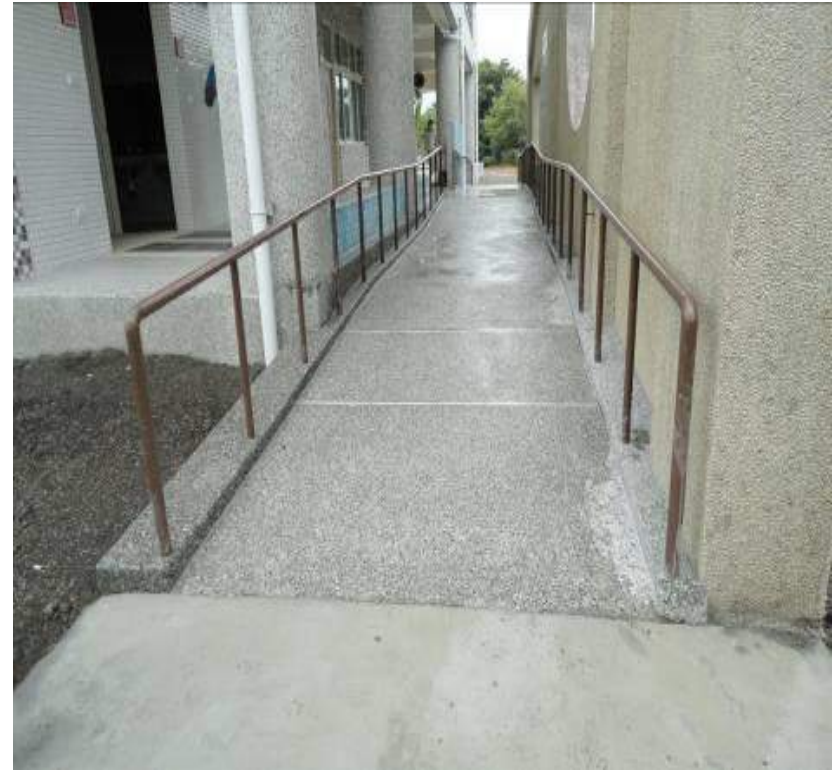
坡道扶手端部防勾撞處理
