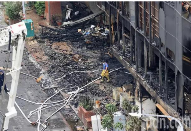
高雄市鹽埕區城中城大樓火警，目前消防局搜救已告一個段落。本次火警共造成41人受傷，46人！亡。記者林伯東／攝影
