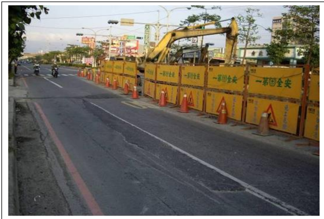
照片 02 管溝開挖工作場所周圍以移動式圍籬、交通錐等圍成警示區
