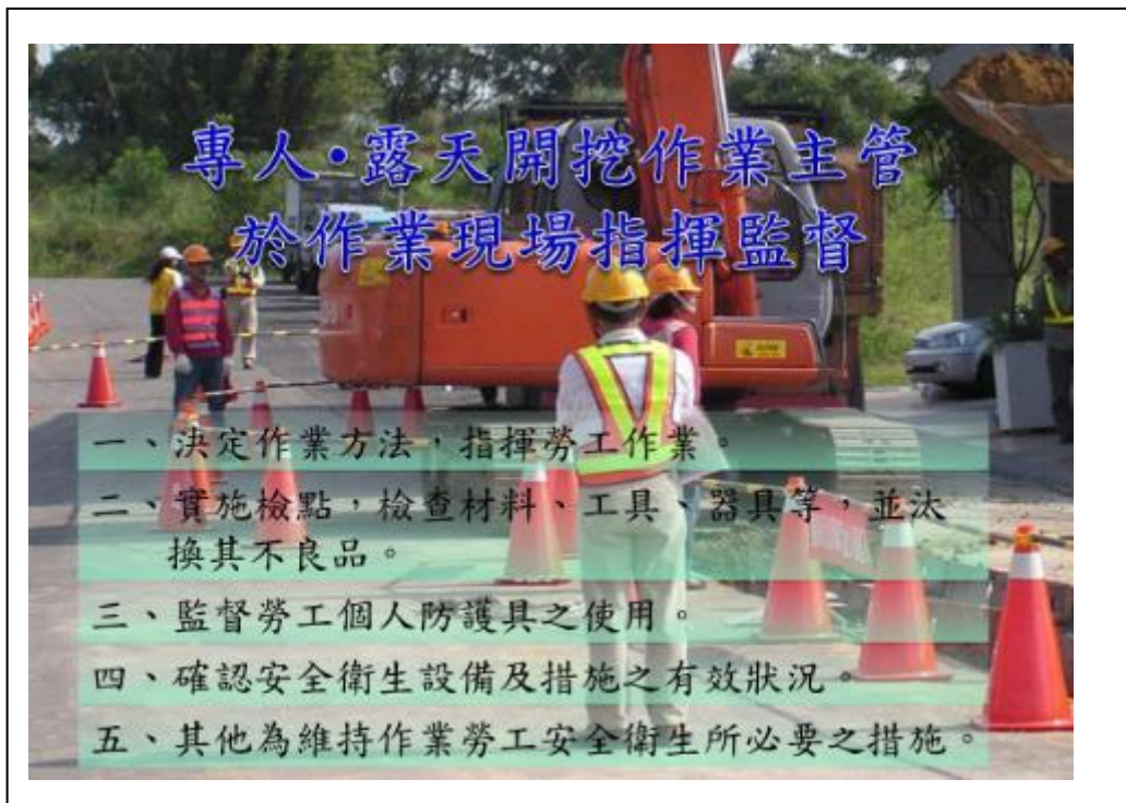
照片 12 管溝開挖作業期間，受指派之專人或露天開挖作業主管人員，應於「作業現場」辦理法定職務
