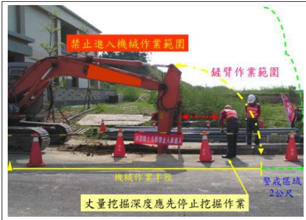
照片 11 挖掘深度測量，應在引導人員指示機械操作人員停止機械動作後，才能進入溝內
