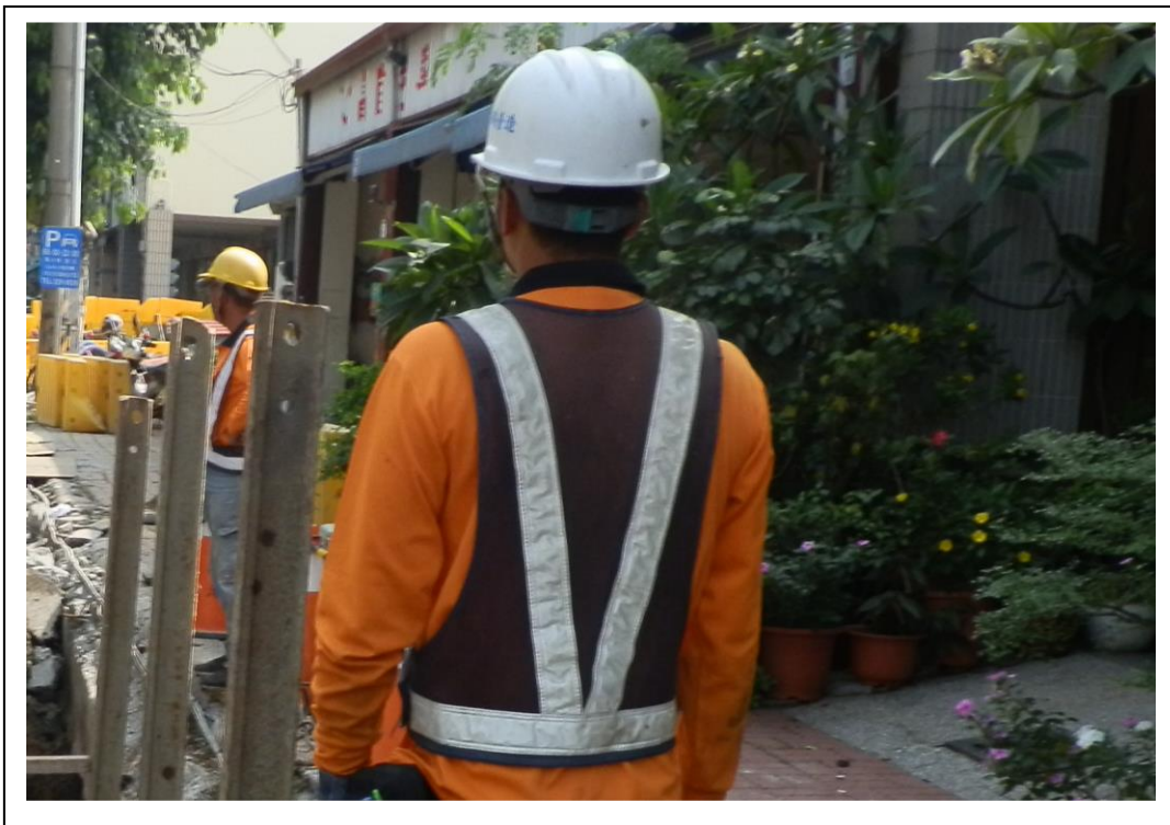
照片 20 管溝作業進行回填時，正確穿戴安全帽、反光背心等
