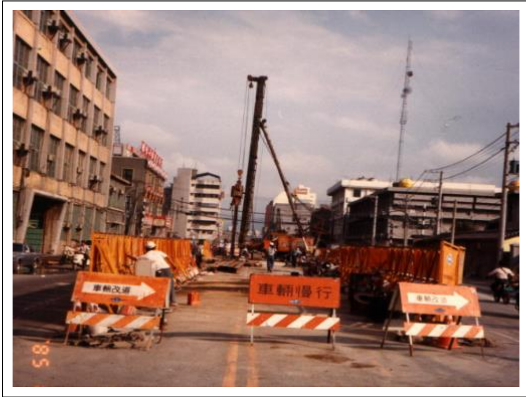
照片 03 露天開挖(打樁作業)工作場所周圍以移動式圍籬、交通標識等圈圍成警告標示
